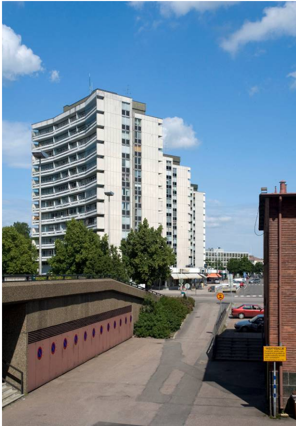
Kuva 12. Näkymä Pohjolatalolta kohti Torikadun tornitaloja. Oikealla Kauppahallin länsipääty.
