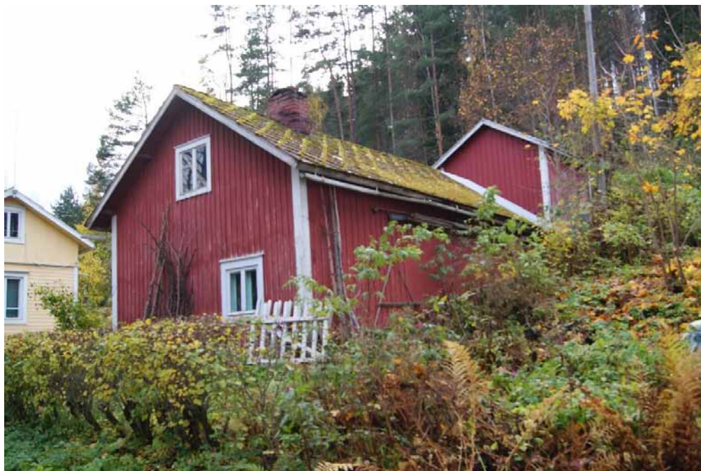
Kuvassa edessä rakennuksen 2 julkisivu koilliseen ja luoteeseen. Kuvassa takana rakennuksen 3 julkisivua koilliseen ja luoteeseen.
