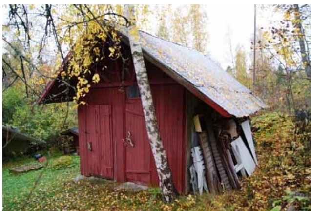
Julkisivu länteen ja pohjoiseen
