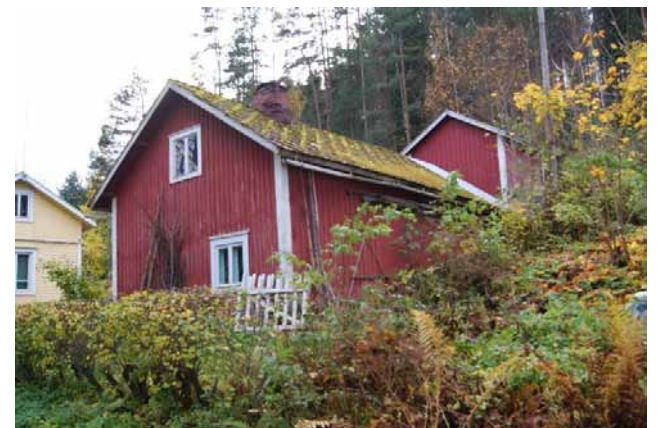
Kuvassa edessä rakennuksen 2 julkisivu koilliseen ja luoteeseen. Kuvassa takana rakennuksen 3 julkisivua koilliseen ja luoteeseen.
