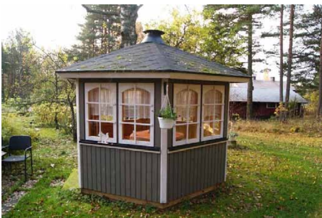
Julkisivu itään ja pohjoiseen
