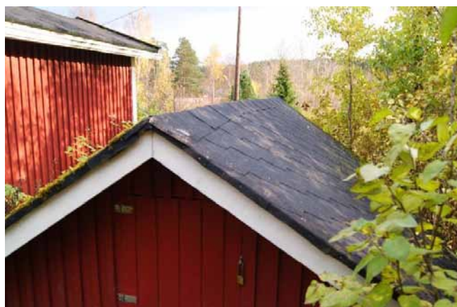
Julkisivu etelään (katto)
