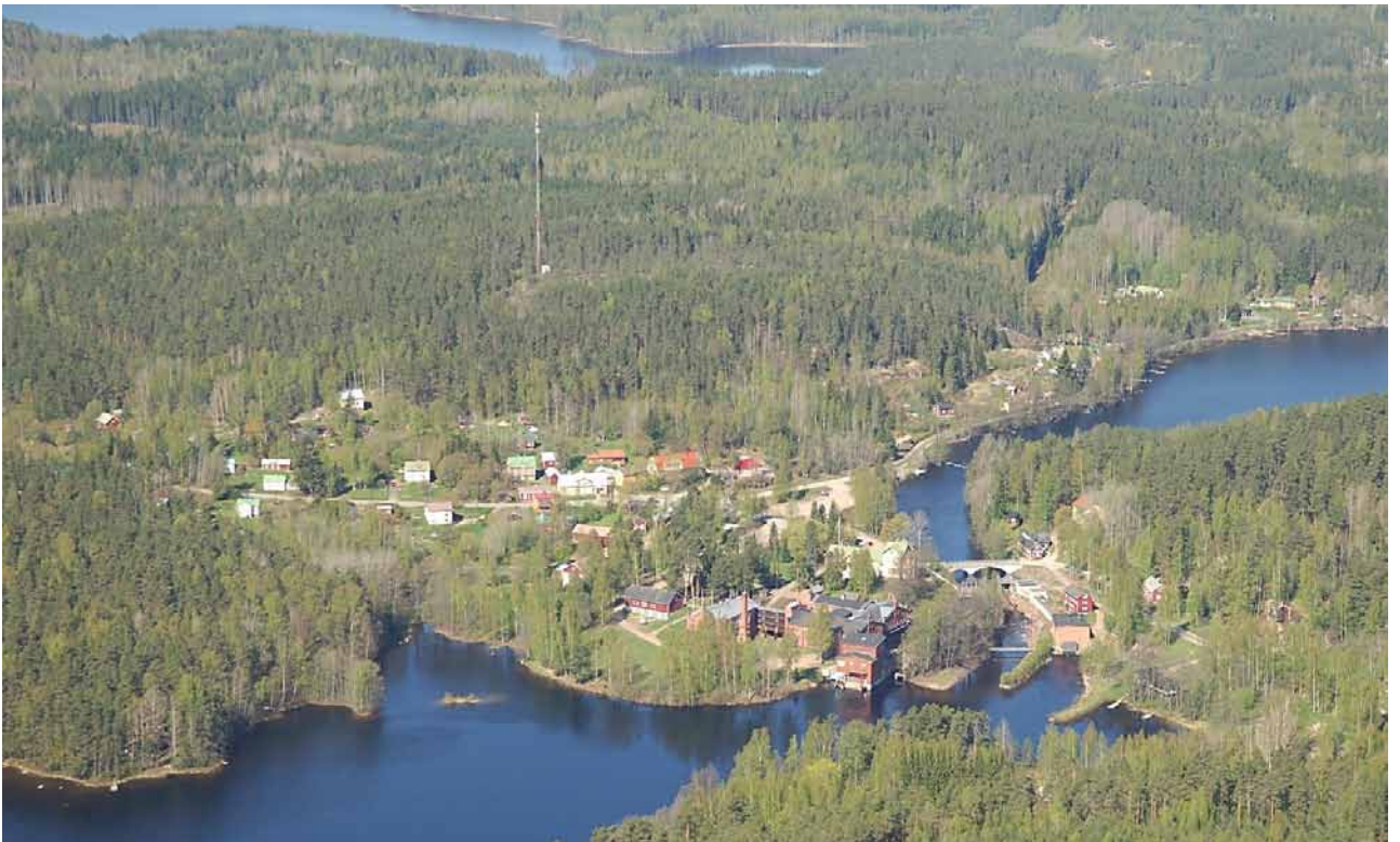
Kuva 5. Viistoilmakuva idästä kohti Verlan tehdasta ja sen takana olevaa kylää. Kuva Suomen Ilmakuva Oy 9.5.2017.
