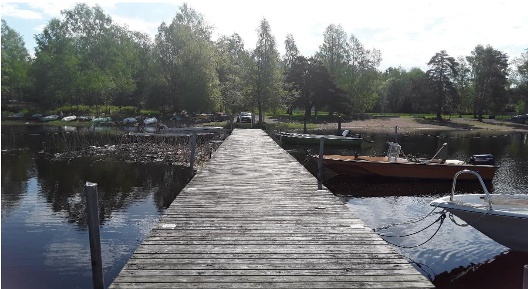
Kuva 7 Jokelan laituri vaatii kaislan poistoa hieman.
