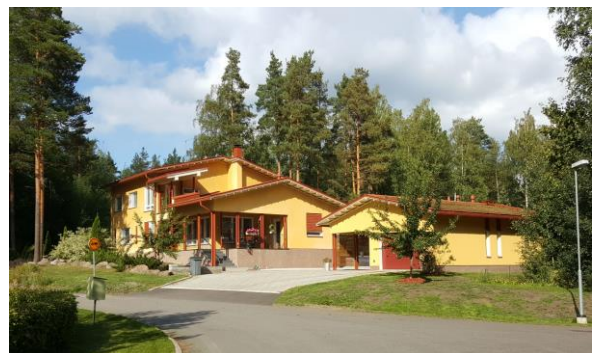
Kuva 15. 2000-luvun rakentamista alueen pohjoisosassa.
