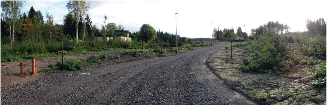
Kuva 8. Yleisnäkymä Kesärannan eteläosasta, jossa maasto nousee kohti Niskalantietä.
