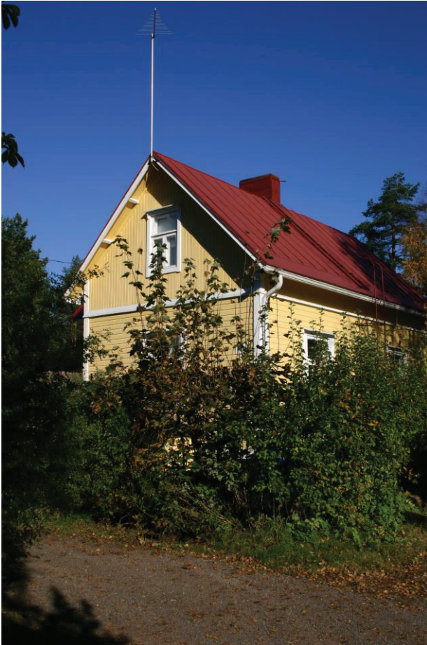
Kuva: Konesaumattu peltikatto
