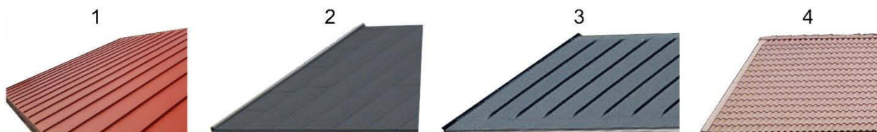
Kuva 15. Alueella käytettäviä katemateriaaleja: 1 konesaumattupelti, 2 bitumikermi, 3 kolmiorimakate (bitumikermikate) ja 4 savi-/betonitiilikate. Katteenväri vaihtoehdot ovat musta, punainen, savitiilenpunainen, harmaa, tummanharmaa, ruskea ja tummanruskea.
