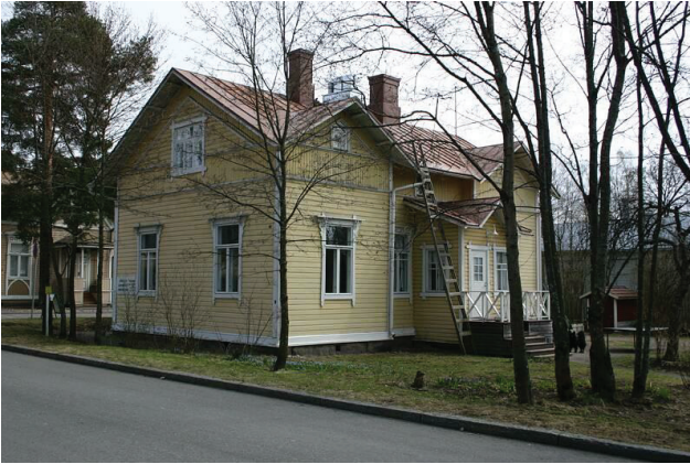
Konesaumattu peltikatto ja harjalla pellitetyt piiput
