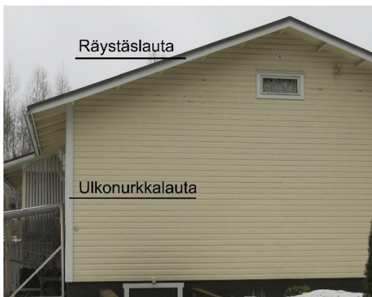
Kuva 29. Ulkonurkka- ja räystäslaudat maalattiin joko muun julkisivun väriin tai valkoisiksi.
