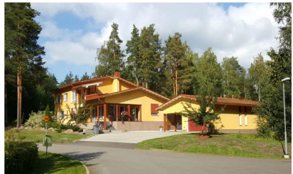
Kuva 15. 2000-luvun rakentamista alueen pohjoisosassa.
