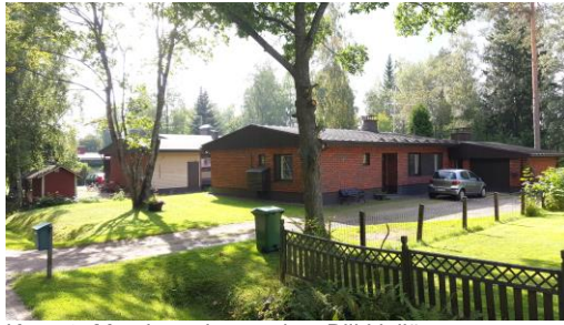
Kuva 3. Matalaa rakentamista Riihitiellä.
