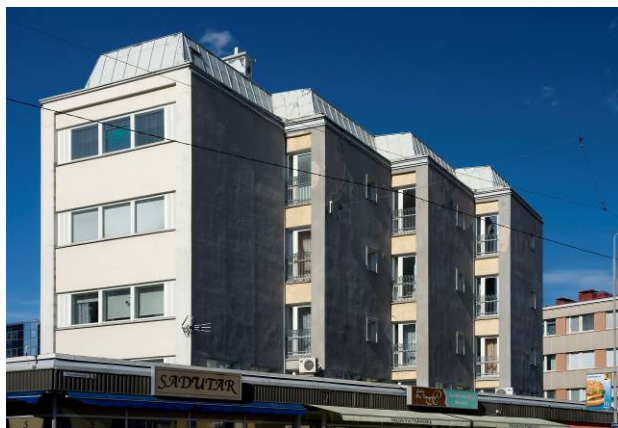
Kuva 12. As Oy Torinportin porrastettu asunto-osa.
