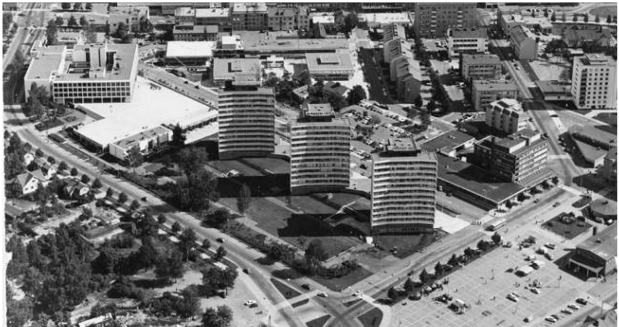
Kuva 7. Keskustakorttelit ennen Hansakeskuksen uuden osan rakentamista.
