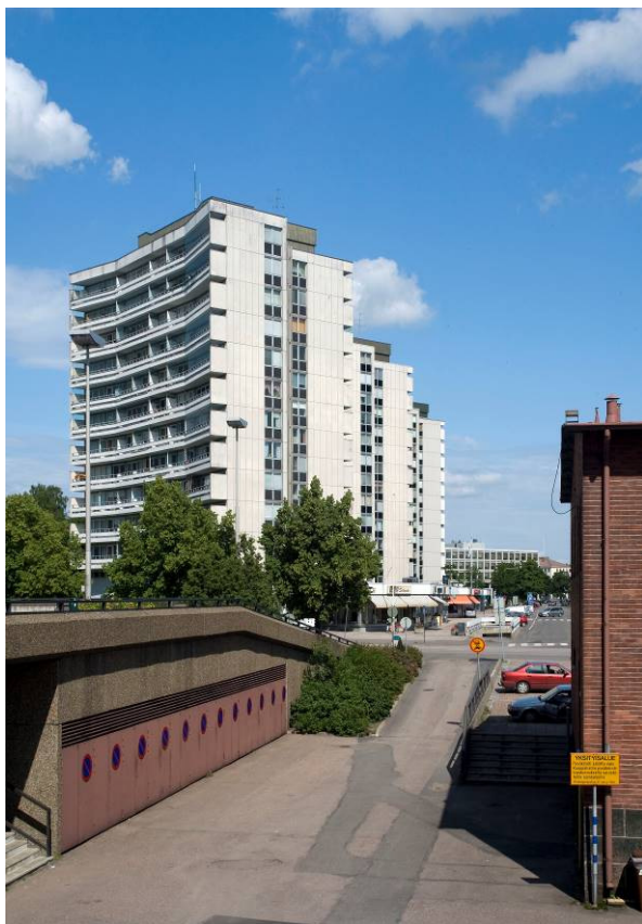
Kuva 10. Näkymä Pohjolatalolta kohti Torikadun tornitaloja. Oikealla Kauppahallin länsipääty.
