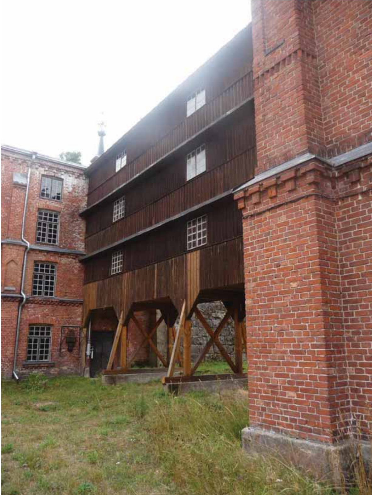
15. Kuivaamon ja jälkikäsittelyn välinen tehtaaseen johtava käytävä.
