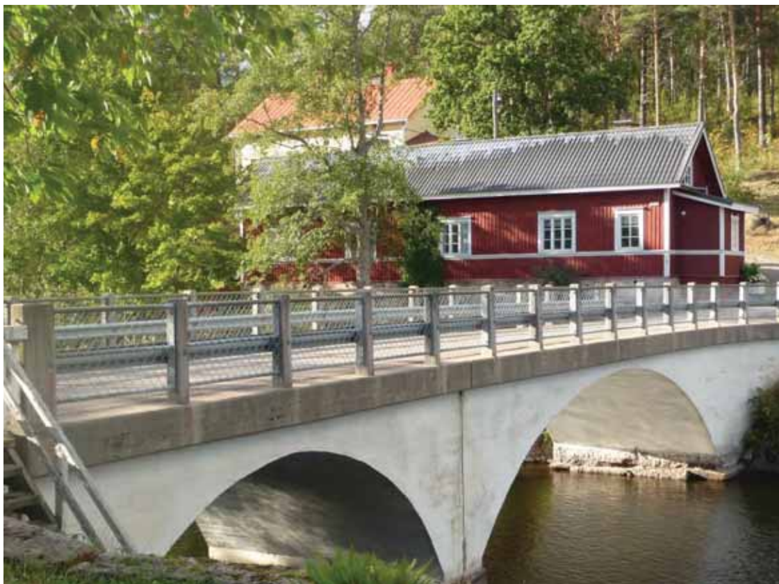
31. Betonisilta vuodelta 1926 ja asuinrakennus VB 2. Takana virkamiestalo VB 1.
