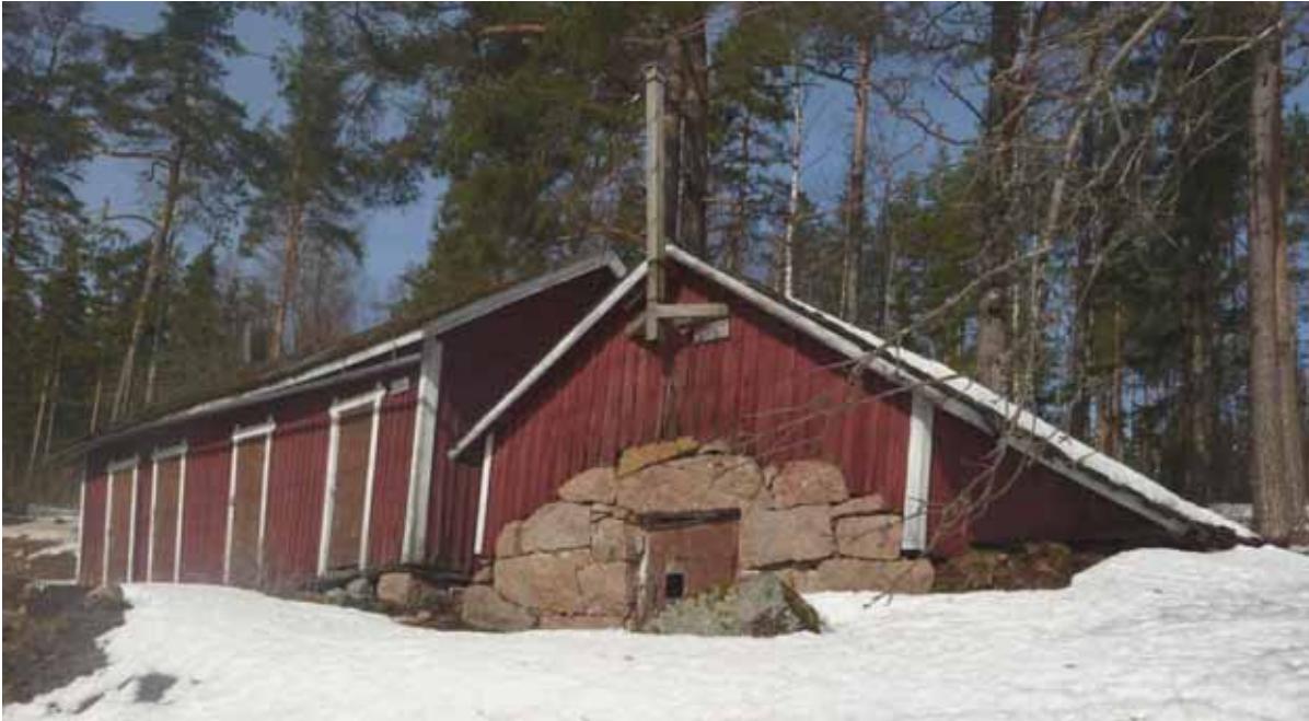
97. Vasemmalla ulkorakennus VU 5 a ja oikealla kellari VU 5 b.
