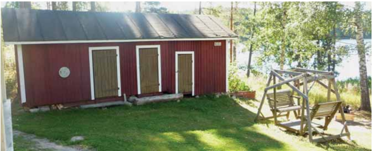
123. Ulkorakennus (VU 13 a).
