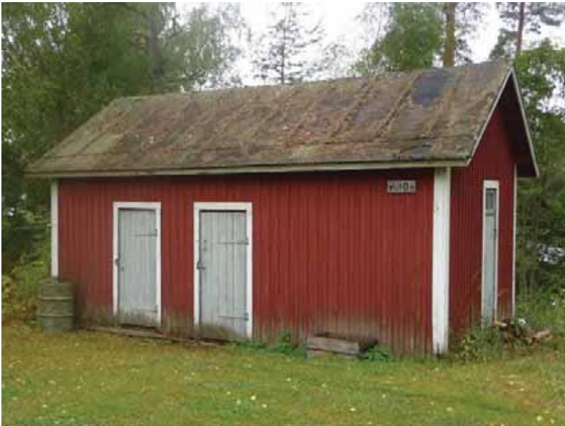
111. Seppälänmäki, piha-rakennus (VU 10 a).
