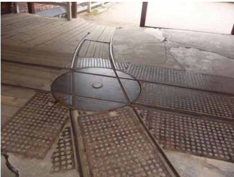
35. Tehtaan työntökärryjen raiteita.
