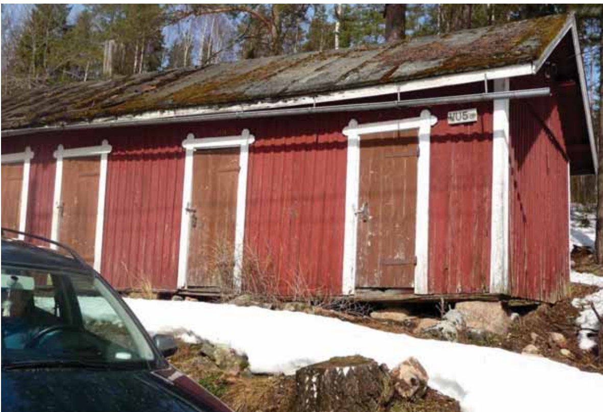
98. Ulkorakennus (VU 5 a).
