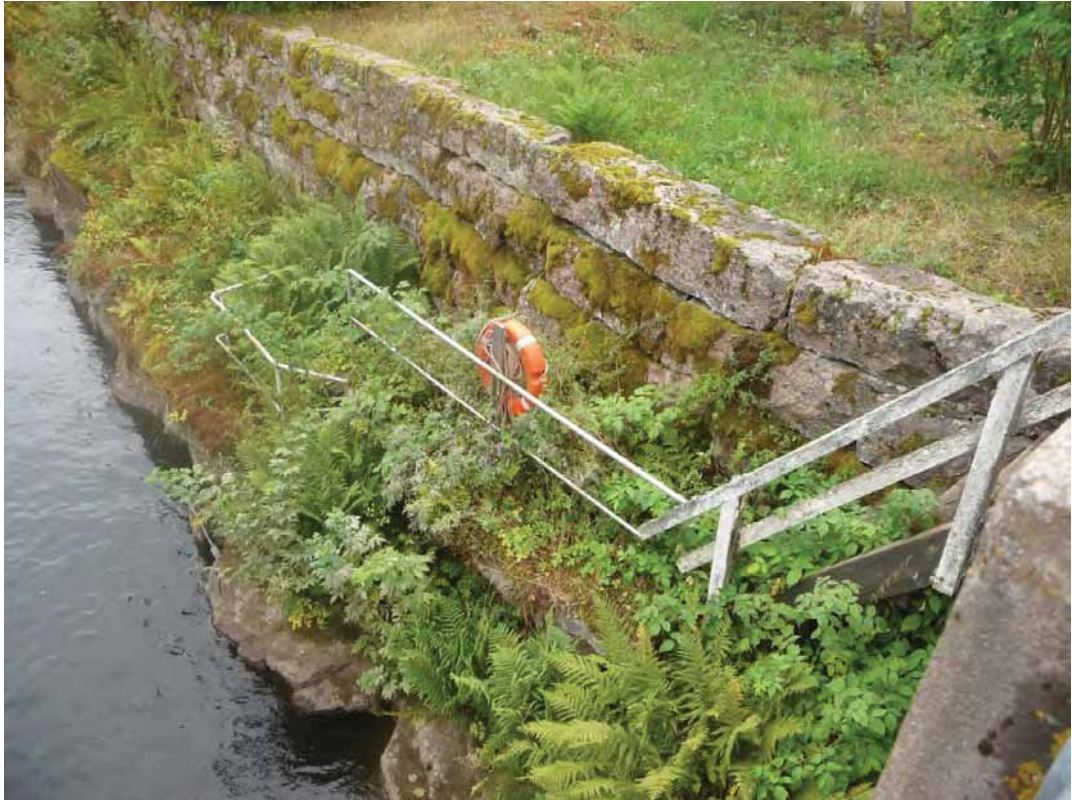
32. Sillalta alas johtavat puuportaat ja kivilohkareilla padottua kanavan seinämää.
