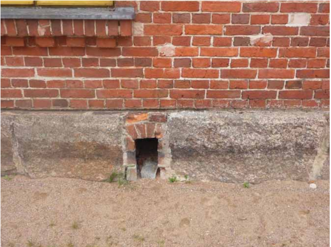
229. Kuivaamon seinää, detalji.
