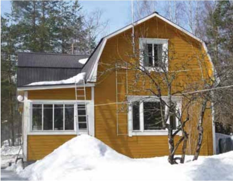
174. Asuinrakennus pihan puolelta.
