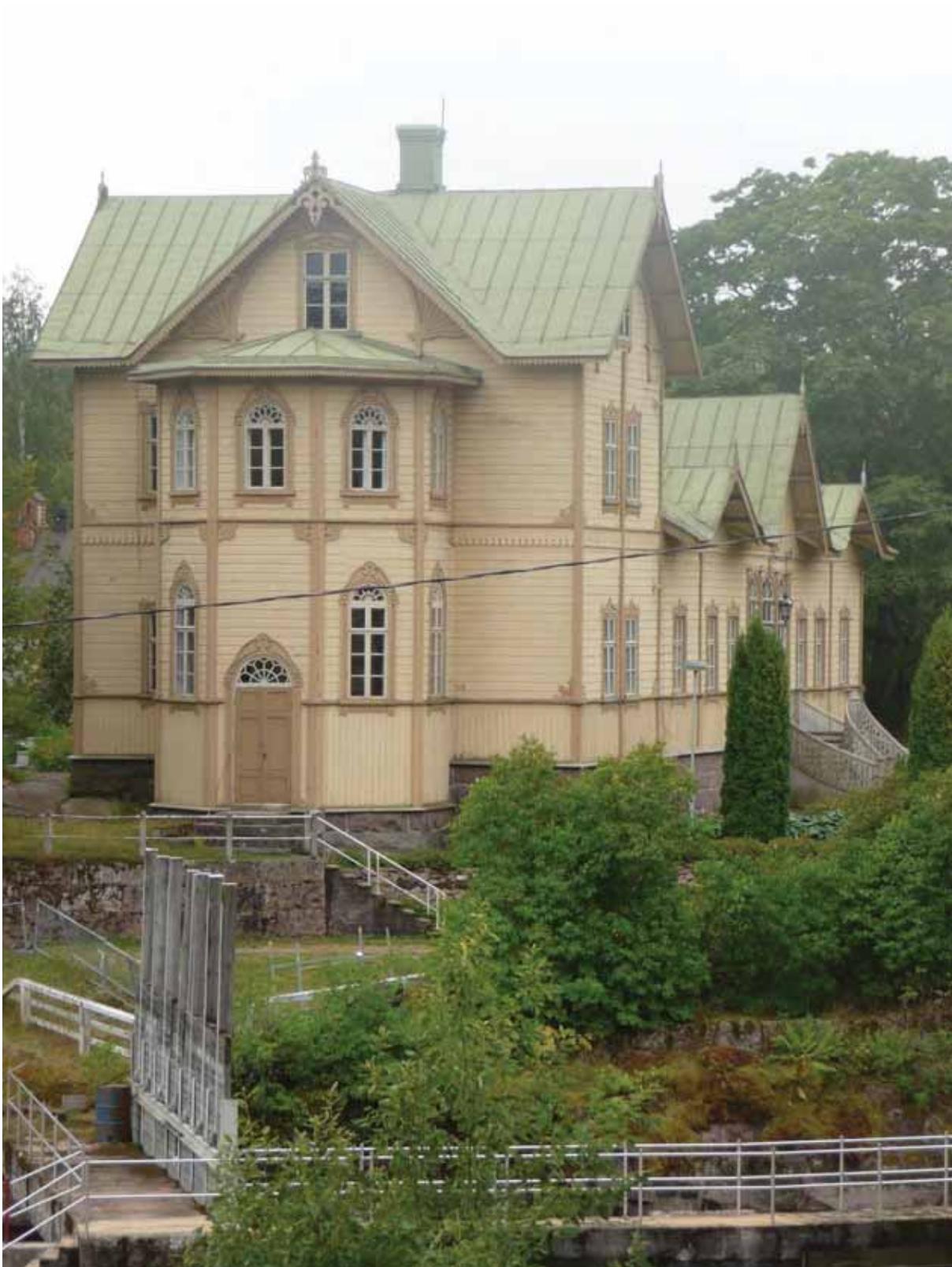
48. Patruunan pytinki (JB 1) Valkealan puolelta nähtynä.
