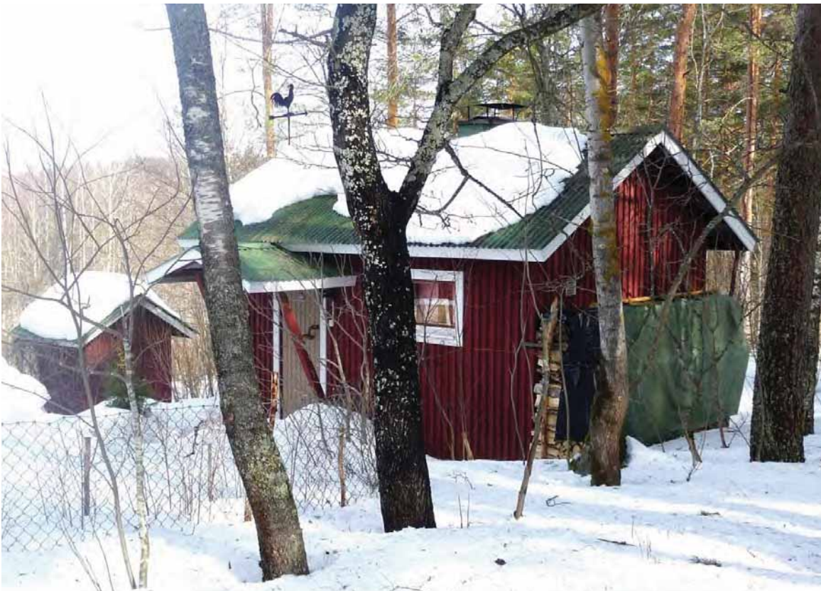
170. Piharakennus II eli sauna, ja pienempi ulkorakennus (94).
