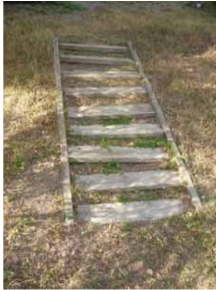
95. Valkealan puolen puuportaita.
