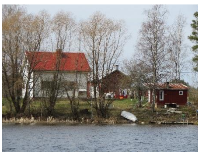
Kuva 23. Osa talouskeskuksista on peräisin 1950-luvulta.
