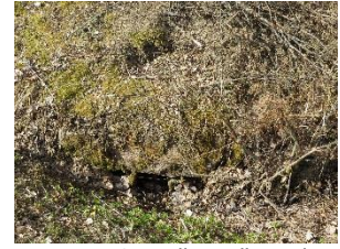
Kuva 14. Osa ojista alittaa tien graniittipaasista tehtyjä rumppuja pitkin.
