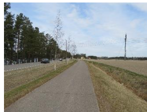
Kuva 16. Tien yhteyteen on rakennettu kevyen liikenteen väylä.
