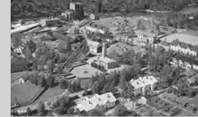
Tehtaan ympäristöä vuonna 1936. KKM.
