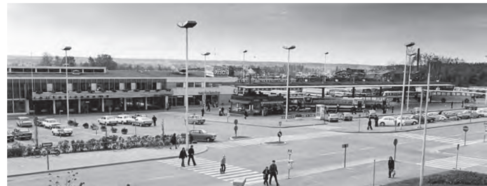
1970-luvulla otetussa valokuvassa Kouvolan aseman edusta alkaa jo näyttää nykyisen kaltaiselta. Asemalle johtavat puurivit ja ympyrän muotoinen nurmialue ovat väistyneet uusien liikennejärjestelyjen tieltä. Katos ja kahvila on rakennettu. KKM.
