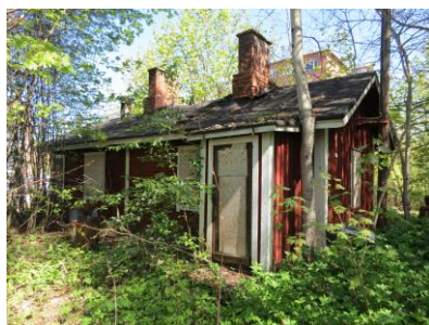
Kuva 15. Ratapiirin rakennusmestarin talon sauna- ja varastorakennus.
