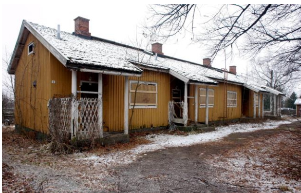
Kuva 8. Eteläisin VR:n entisistä asuinrakennuksista.
