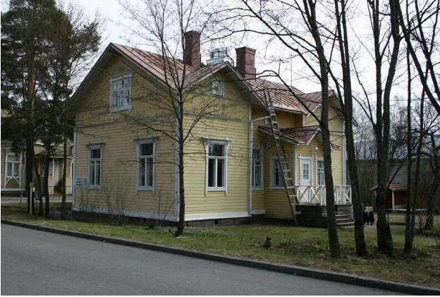
Konesaumattu peltikatto ja harjalla pellitetyt piiput
