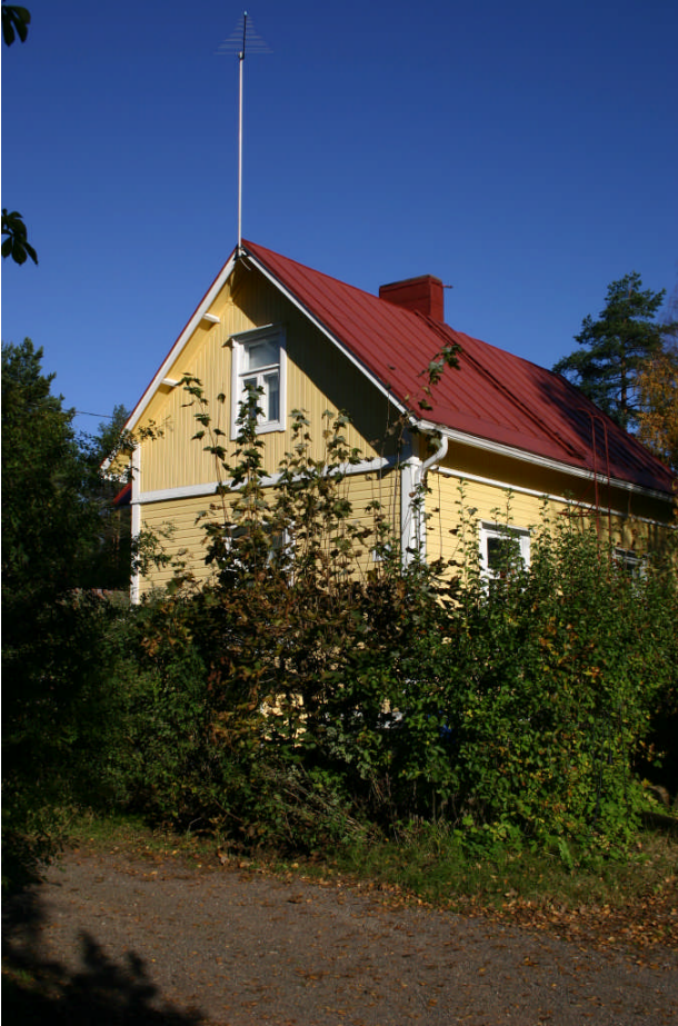
Kuva: Konesaumattu peltikatto
